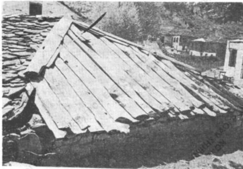
Εἰκ. 1. Στέγη ἐκ πλακῶν καὶ κορμῶν δένδρου.
