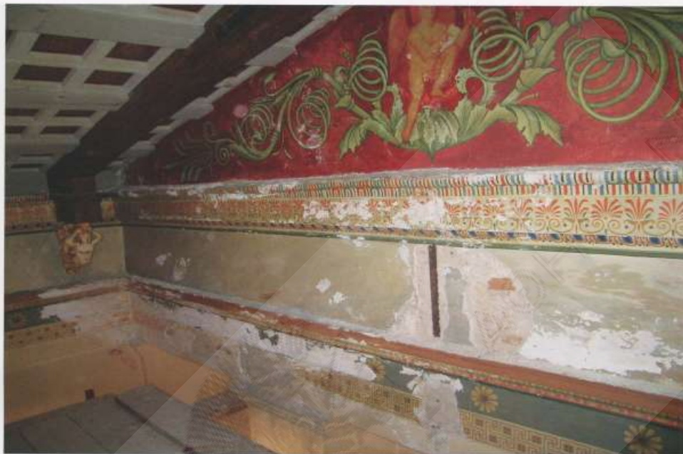
Εικ. 18. Η μία από τις δύο πλευρές του Μουσειακού χώρου Β' που φέρουν αέτωμα. Παρουσίαζε απώλειες κονιάματος, απολεπίσεις ζωγραφικού στρώματος, αποκολλήσεις κονιάματος και ρηγματώσεις.
