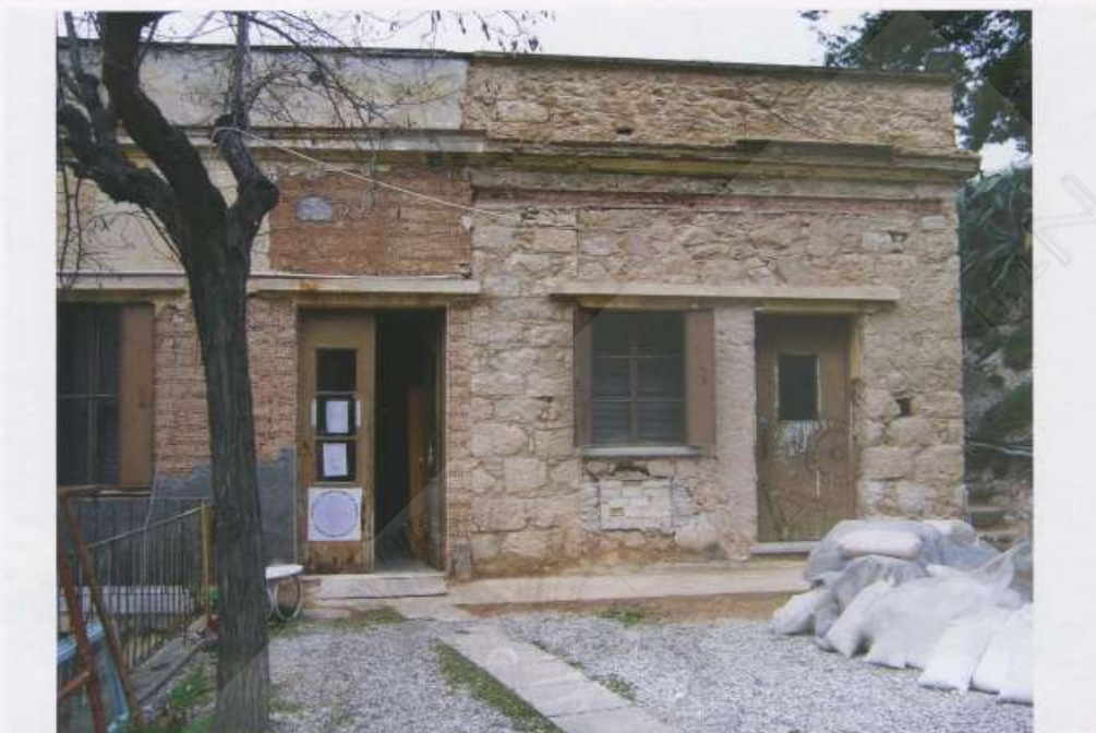
Εικ. 33. Το κτήριο του πρώην Ιονοσφαιρικού πριν τις εργασίες αποκατάστασης.
