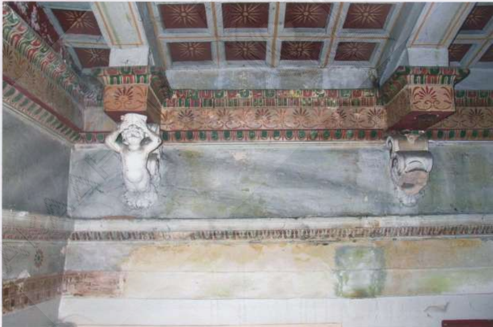
Εικ. 10. Παρουσία της υγρασίας με τη μορφή κίτρινων λεκέδων.
