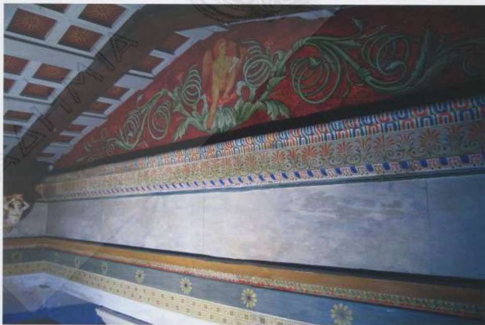
Εικ. 19. Η πλευρά του Μουσειακού χώρου Β' μετά την συντήρηση και την αισθητική αποκατάσταση.
