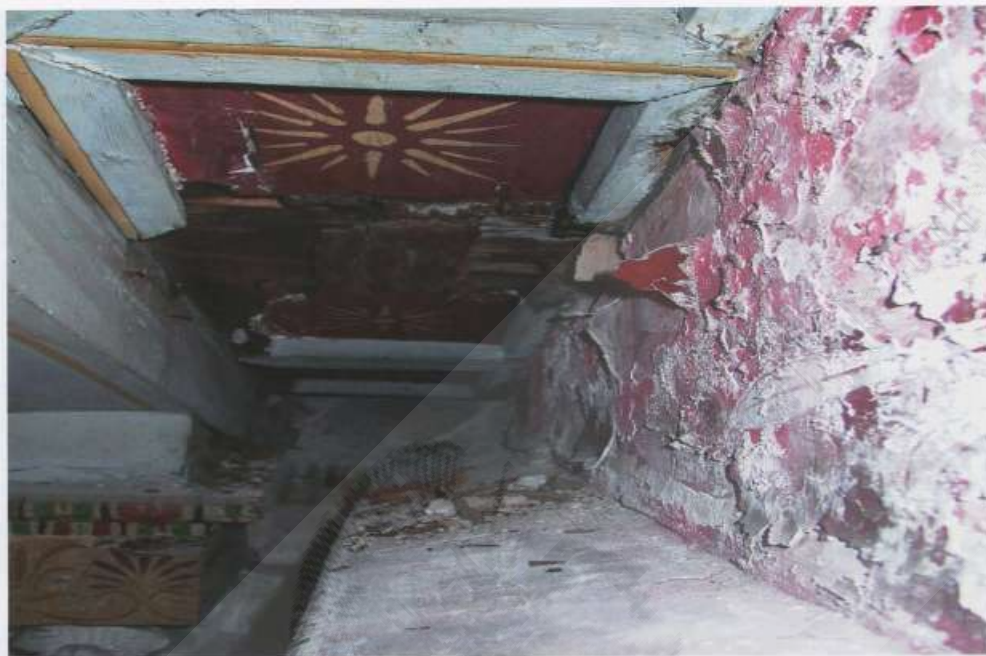
Εικ. 11. Υδρόλυση του ξύλινου φορέα και απώλεια τμημάτων ξύλου.
