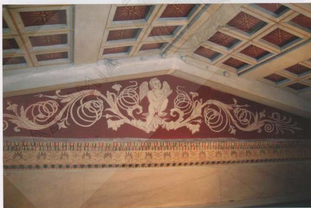
Εικ. 17. Το παραπάνω αέτωμα μετά τις εργασίες συντήρησης και αποκατάστασης.
