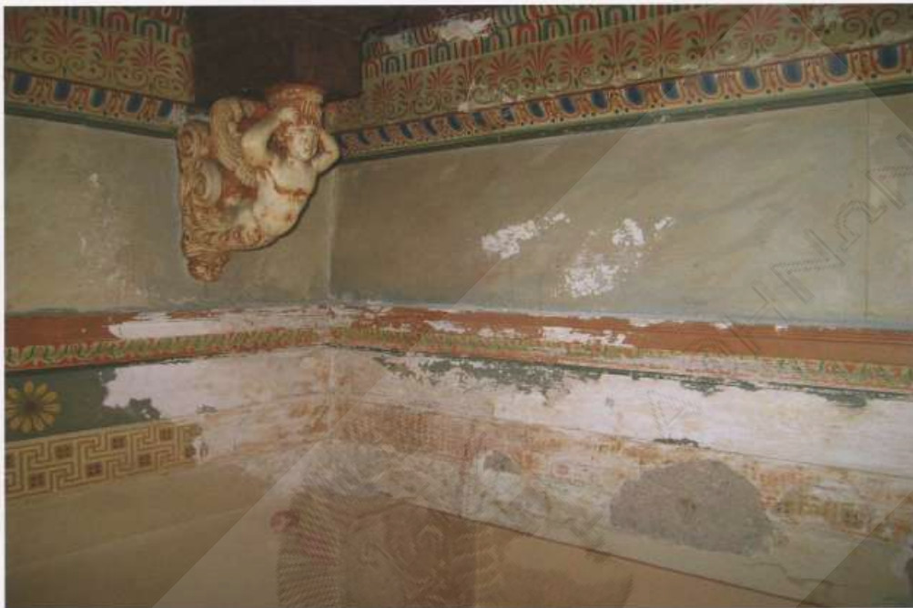
Εικ. 7. Απώλεια και απολέπιση του ζωγραφικού στρώματος.
