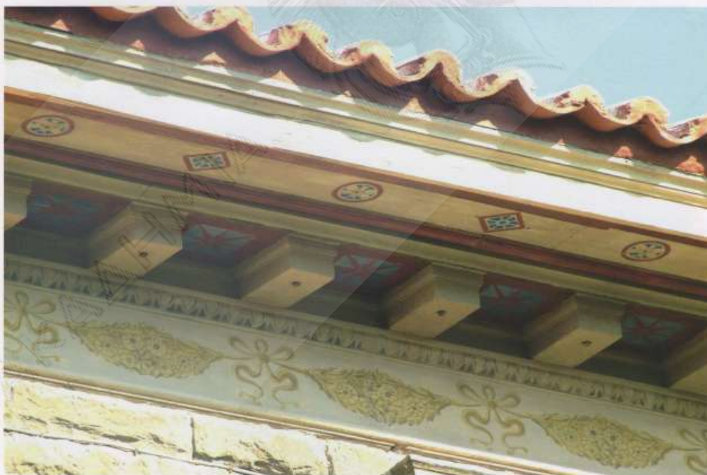
Εικ. 28. Η στέγη του κτηρίου Ziller μετά τις εργασίες συντήρησης και αποκατάστασης.
