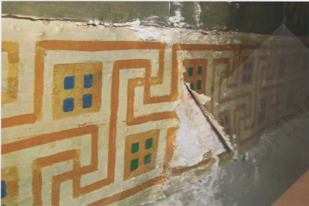
Εικ. 9. Αποκόλληση του ζωγραφικού στρώματος.
