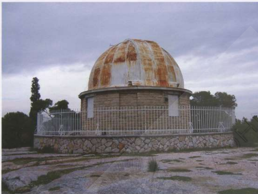
Εικ. 31. Το κτήριο Δωρίδη πριν τις εργασίες αποκατάστασης.
