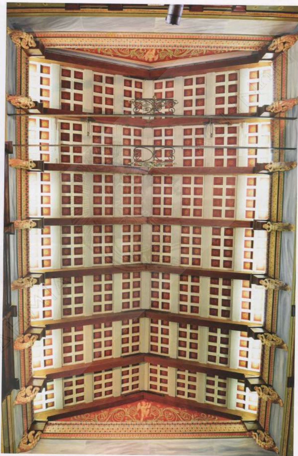
Εικ. 15. Η οροφή της Βιβλιοθήκης μετά την αποκατάσταση.
