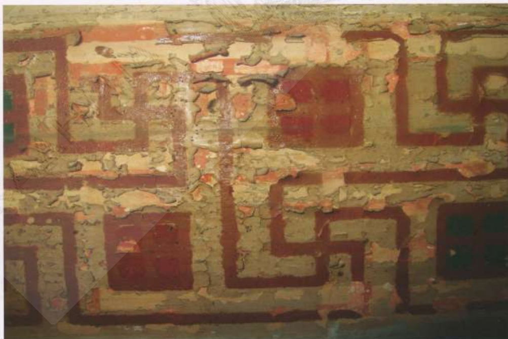
Εικ. 8. Απολέπιση της ζωγραφικής επιφάνειας και εμφάνιση του αυθεντικού ζωγραφικού στρώματος.
