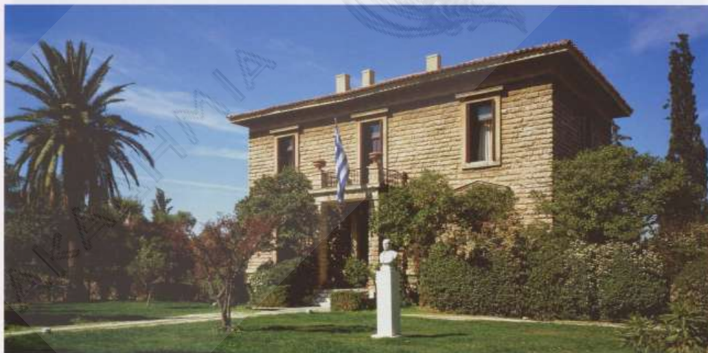
Εικ. 8. Το Διοικητήριο, σε σχέδια Ziller, μετά την εξωτερική αποκατάσταση (2008) (Φωτογρ.: Ε. Αττάλι).
