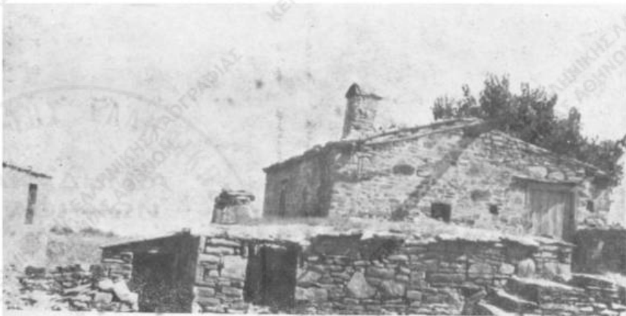
2. Παλιό μονόσπιτο με την άξάτα ύψουμένην ἀνωτέρω τοῦ δαπέδου τοῦ ἀνωγείου καὶ προεκτεινομένην πλαγίως ἐν Φυσίῃ. Βλέπε τὴν μεσοδόκην τῆς στέγης προεκβαλλομένην ἔξω τοῦ προσθίου τοίχου.
