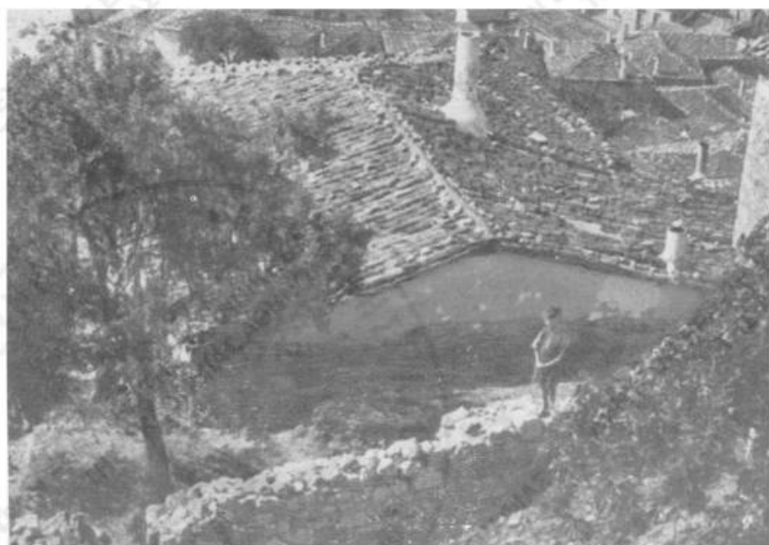
2. Στέγη της αυτής οικίας.
