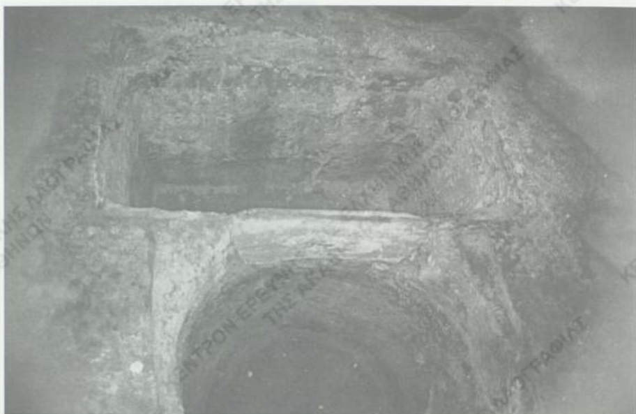
Εικ. 15. Διαμορφωμένες γούρνες διαχωρισμού με κινητά ενδιάμεσα τμήματα.
