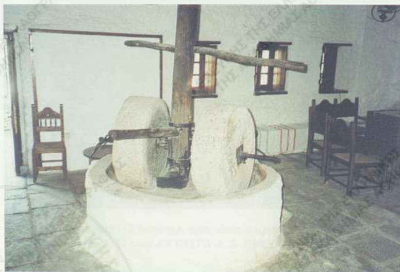
Εικ. 8. Ζωοκίνητο λιοτριβί με δύο μυλόπετρες, που έχει αποκατασταθεί και λειτουργούσε ως καθιστικό σε ξενώνα του ΕΟΤ στη Βάθεια Μάνης (Βάθεια 1996, φωτ. Α. Οικονόμου).
