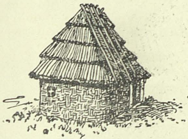
Εἰκ. 52. Πρωτόγονος διθάλαμος οἰκίσκος, ἔχων τοὺς τοίχους ἐκ πλέγματος ῥάβδων, τὴν δὲ στέγην ἐκ χόρτων. (Meringer, Volkst. Haus in Bosnien, εἰκ. 5)
